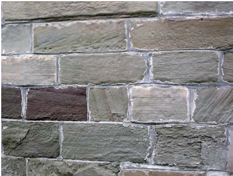
Abb. 20.5 Mauer aus grünem Lettenkeuper-Sandstein am Weidnerhof im Freilandmuseum Wackerhofen bei Schwäbisch Hall. Wie die unterschiedlichen Schichtungen zeigen, wurden die Steine nicht lagerhaft zusammengestellt. Einzelne Steine aus dunkelviolettgrauem Blutsandstein von Übrigshausen zeigen, dass man bei Bauernhäusern wenig auf ein einheitliches Erscheinungsbild achtete. Foto H. HAGDORN.
