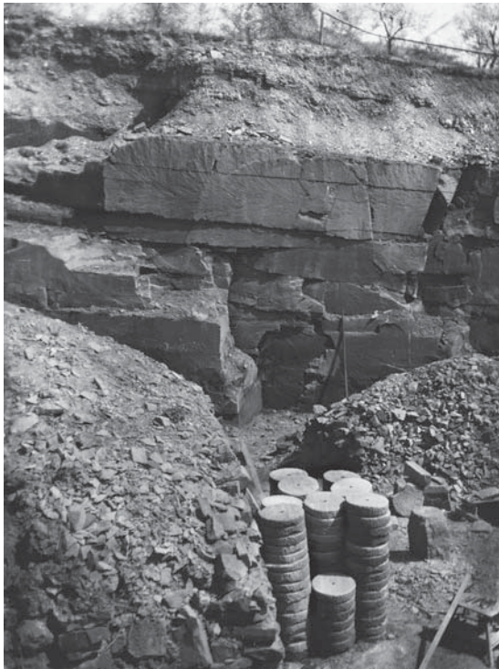
Abb. 20.4 Historischer Sandsteinbruch bei Bedheim. Vorne zu-gerichtete Mühl- und Schleifsteine. Bildvorlage aus Nachlass G. ROSELT, Fotosammlung K.-P. KELBER.
