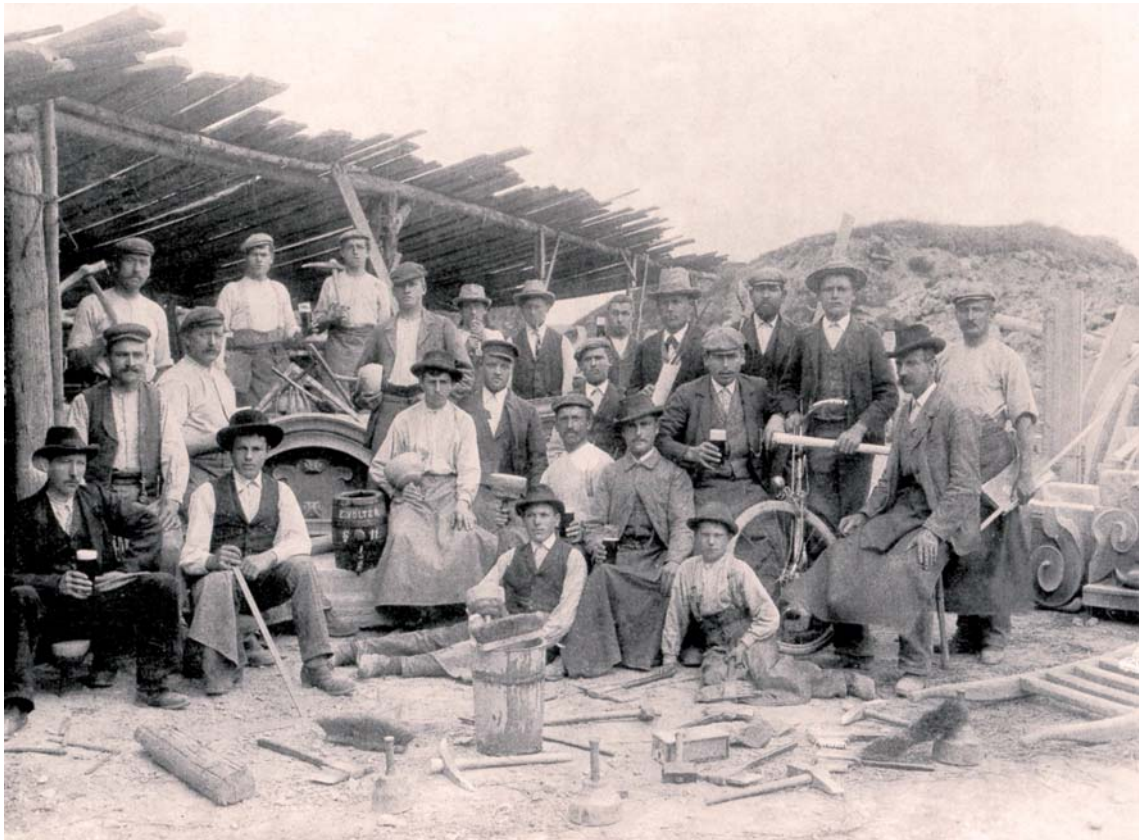
Abb. 20.10 Belegschaft eines Sandsteinbruchs im Biberstal bei Rieden. Im Vordergrund die Steinhauerwerkzeuge Klüpfel, Haue und Spitzseisen. Rechts zugewandene Ornamentsteine, dahinter der Werkplatz (aus HAGDORN 1990).
