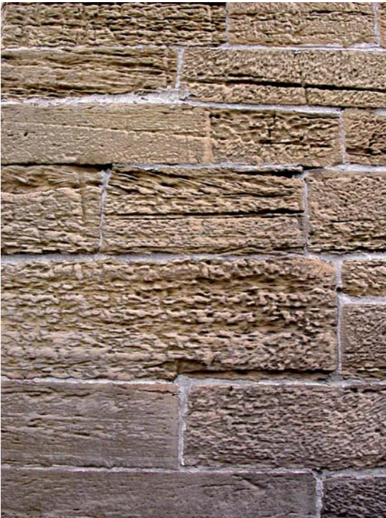
Abb. 20.6 Wabenverwitterung an der Alten Lateinschule in Ingelfingen. Foto H. HAGDORN.
